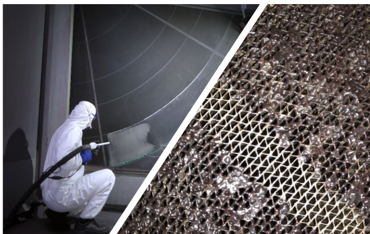
■ Čiščenje termičnega kolesa (premer 5 metrov) s suhim ledom (levo), očiščeni in neočiščeni del satovja toplotnega izmenjevalca (desno).
