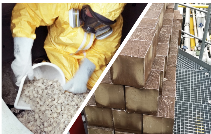
■ Menjava „sedlastega“ keramičnega sloja (levo) in menjava keramičnih blokov na RCO incineratorju v cementarni (desno).
